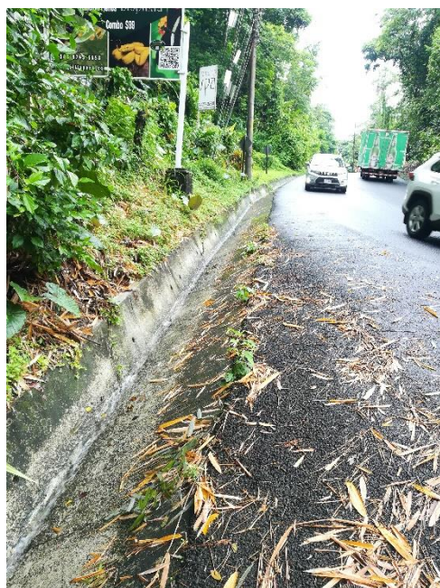
Figura 10. Infraestructura actual para el manejo de la escorrentía de la ruta nacional 618
