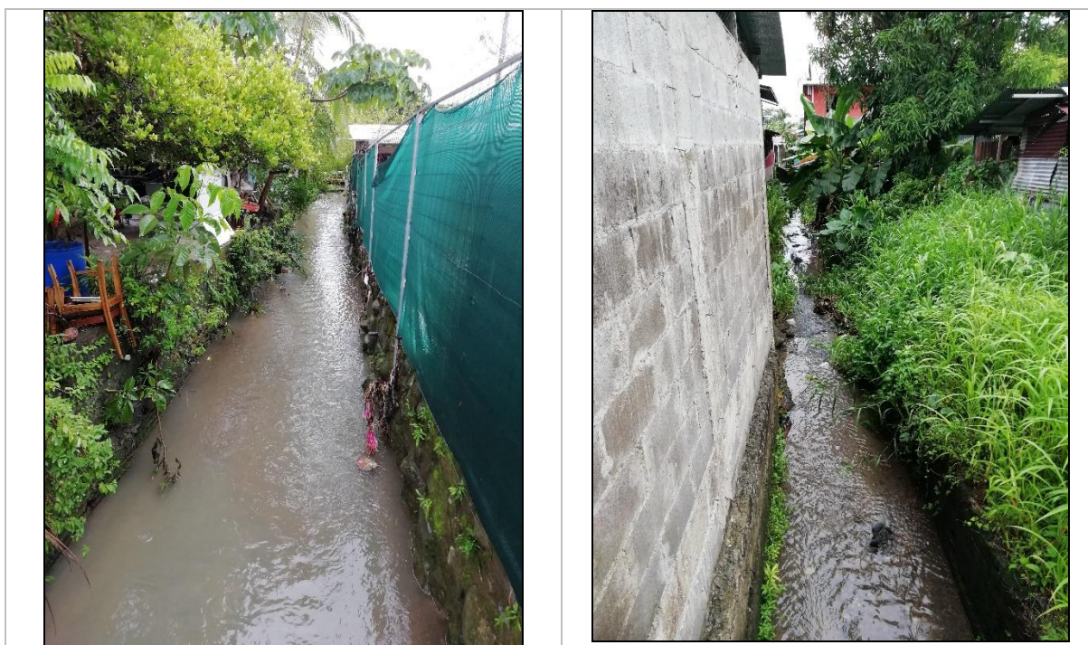
Figura 7. Estrangulamientos de la quebrada Padre en diferentes puntos de su recorrido
