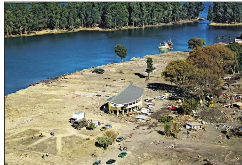
Después de la destrucción causada por las olas del maremoto sólo se mantuvo en pie parte de la Casa de Botes, un moderno recinto municipal equipado con instalaciones para los cultores del canotaje. C12
