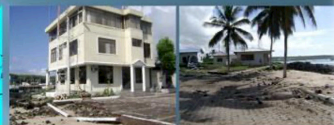
Planchada de CAPAYO Altura: 1.33 metros
