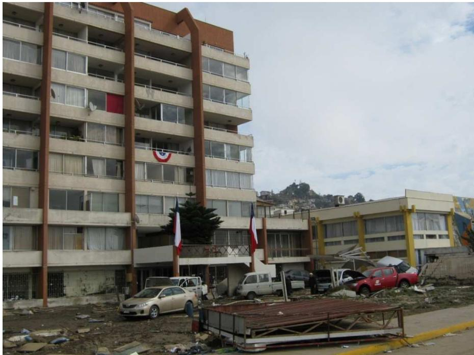
*Figura 35. Efectos del Tsunami en edificio de Av, Costanera, al costado de la Capitanía de Puerto en Coquimbo.*
