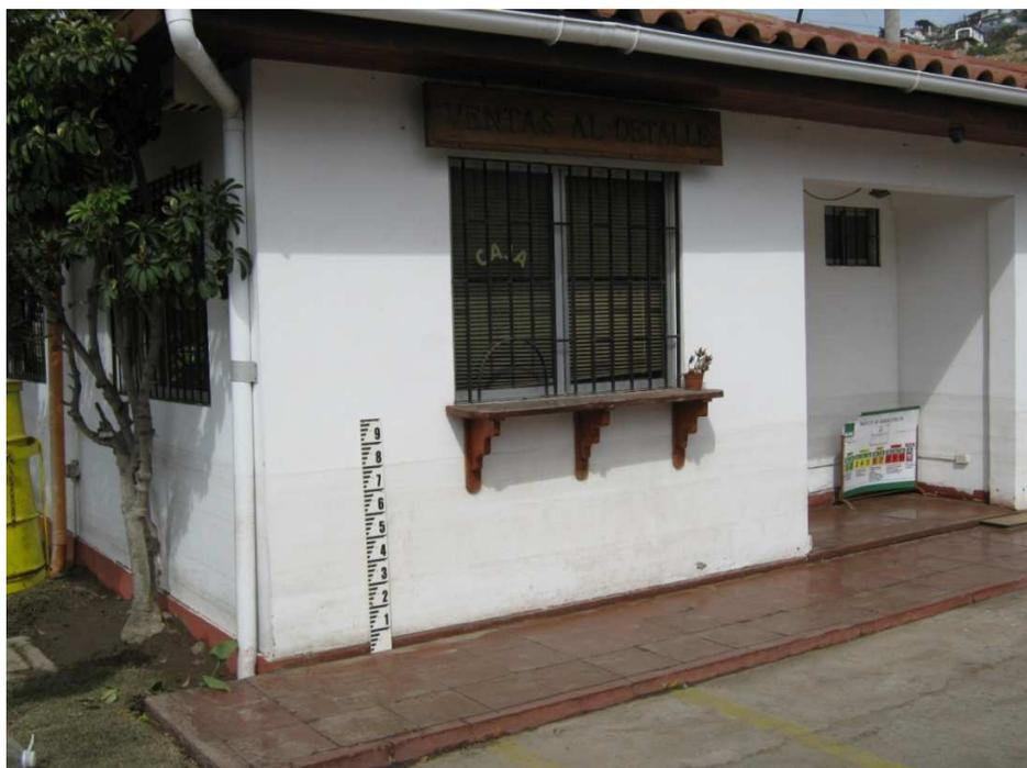
*Figura 37. Profundidad de inundación del Tsunami alcanzado en molinera ubicada en calle Aldunate (0.8 m) en Coquimbo.*
